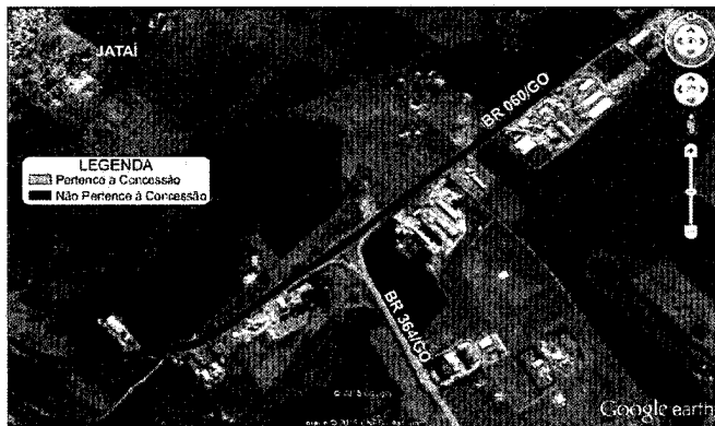
Croqui 1: Limites da Concessão - Extremidade do Lote no Km 192,7, em Jataí - GO.
